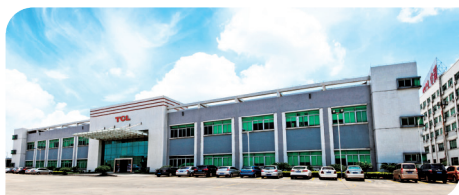
Jiujiang Base (2 εκ. σετ κλιματιστικών)
